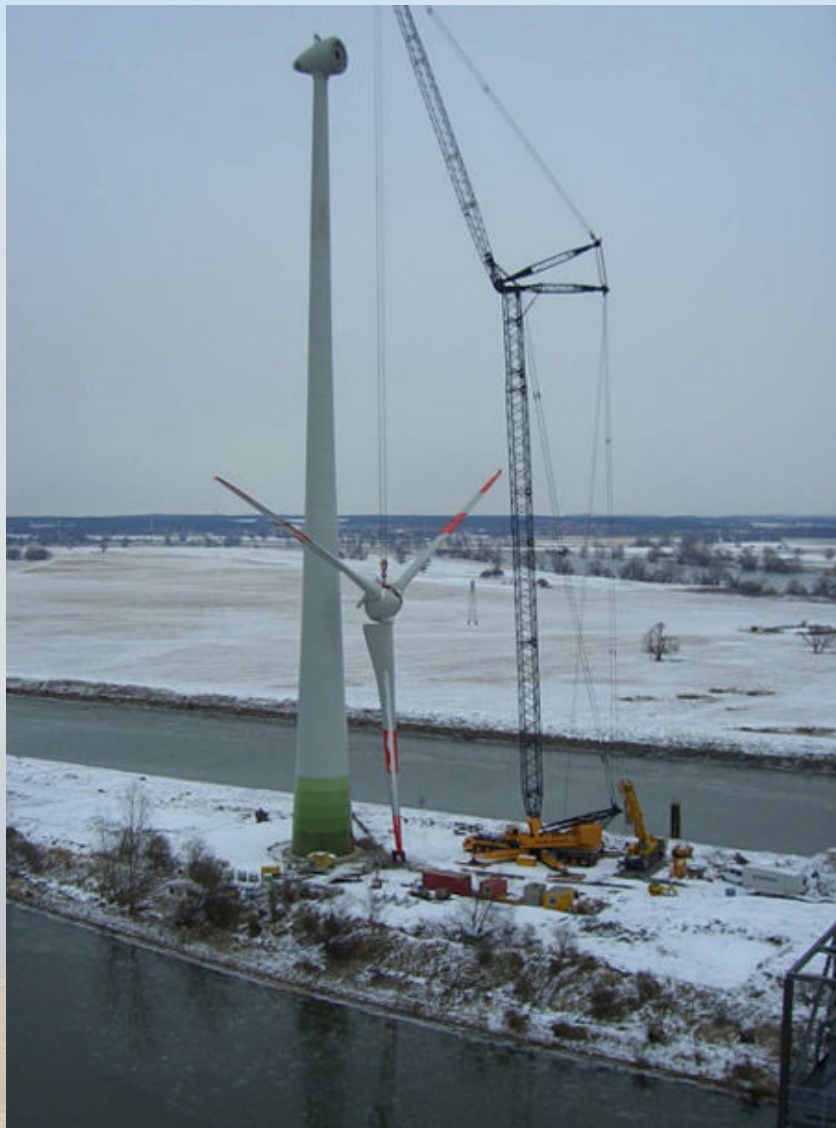
Строительство прибрежной электростанции в Германии.
