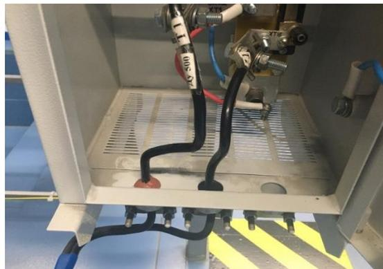
Рисунок 5. Блок диодно-резисторный «Энергомера», ip64, ТУ-3415-006-22136119-04 с нанесенными пробками из ОРП (1 и 2).
