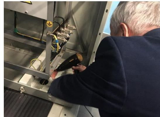
Рисунок 6. Макет катодной высоковольтной защиты с герметизацией нашим ОРП феном.
