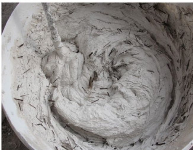
Фото 3. Введение базальтовой фибры в растворы сухих строительных смесей
