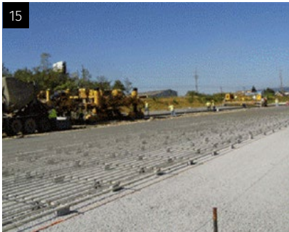
Фото 15, 16. Применение АКБ при строительстве дорог с бетонным покрытием
