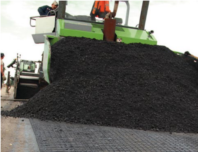
Фото 7. Применение дорожных сеток между щебнем и асфальтом при строительстве дорог
