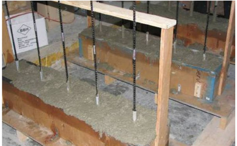
Фото 14. Проведение испытаний образцов АБП на вытязку из бетона
