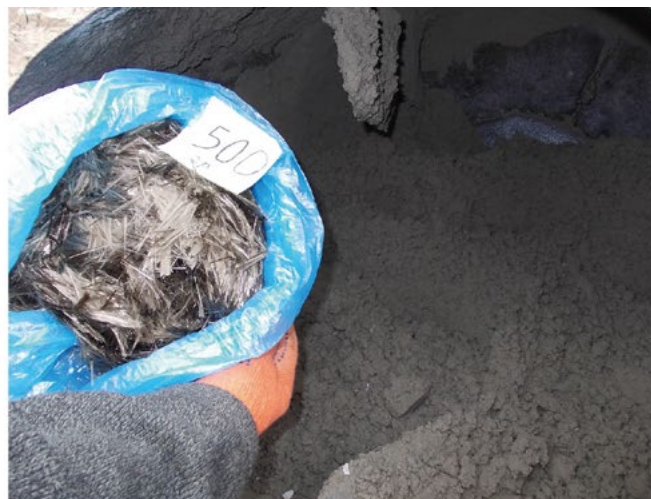
Фото 2. Введение рубленых волокон d = 18\text{--}21 микрон, длиной 25 мм в бетонную смесь с фракцией щебня 5–20 мм
