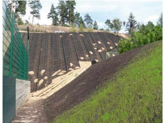
Фото 8. Укрепление насыпей и откосов дорожными сетками
